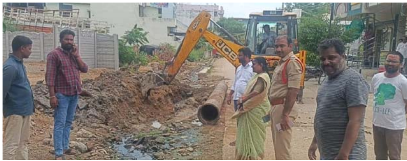
మరిపెడ మున్సిపల్ చైర్పర్సన్ వీసారపు ప్రగతి శ్రీపాల్ రెడ్డి 4,5,8వ వార్డుల్లో డ్రైనేజీ మరమ్మత్తు పనుల పరిశీలన..
