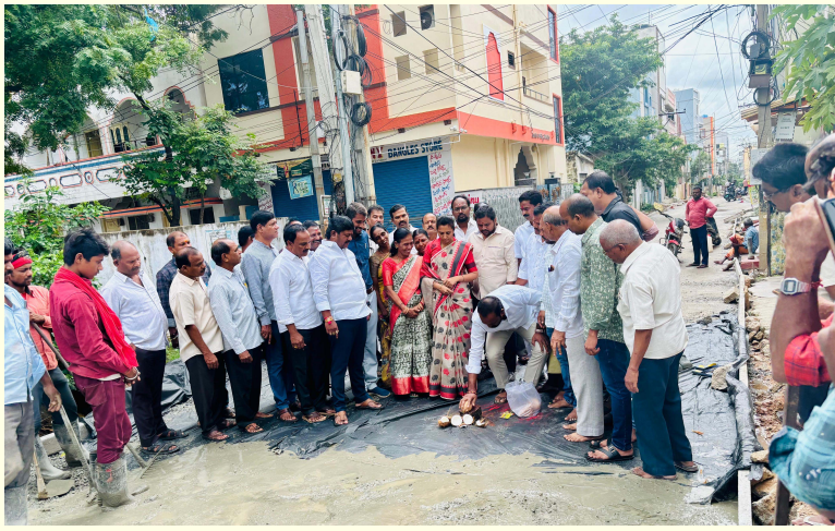
విజయపురి, న్యూవిజయపురికాలనీలో రూ.కోటిన్నరతో జరుగుతున్న సీసీ రోడ్డు నిర్మాణ పనులు.. పనులను పరిశీలించిన కార్పొరేటర్ మందుముల రజితపరమేశ్వర్ రెడ్డి
