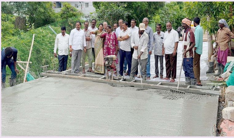
సిసి రోడ్డు నిర్మాణ పనులో నాణ్యత
