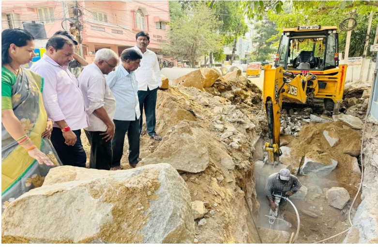
స్ట్రామ్ వాటర్ పైప్ లైన్ పనులు సకాలంలో పూర్తి చేయాలి..
